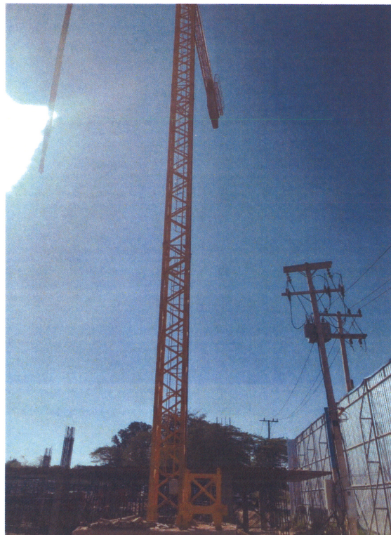
สายไฟแนบชิดกับเสาทาวเวอร์เครน
